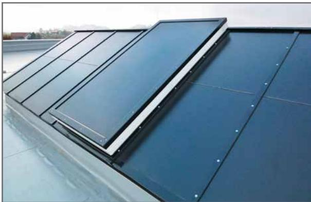
RWA- / Lüftungsflügel
