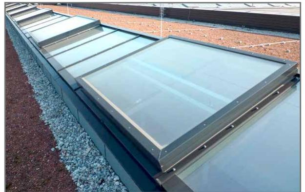
RWA- / Lüftungsflügel
